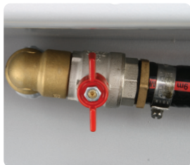
Monterad kulventil och slangnippel 3/4" matningsanslutning.
